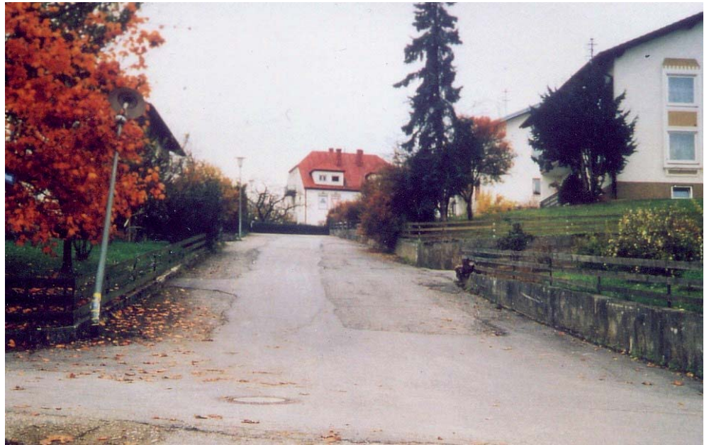
Kapellenstraße vor der Sanierung, 1993
