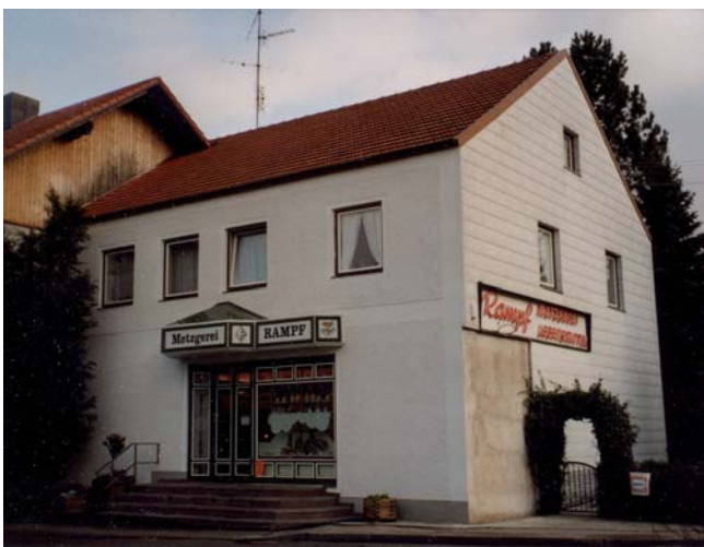
◆ Die Umgestaltung der Metzgerei Rampf ist gelungen.
