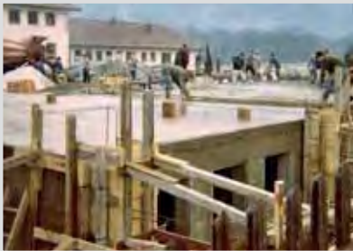
Neubau im Jahre 1969: Decken betonieren.
