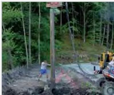
Technisch aufwändig war die Sicherung des Damms mittels Spundwänden.
