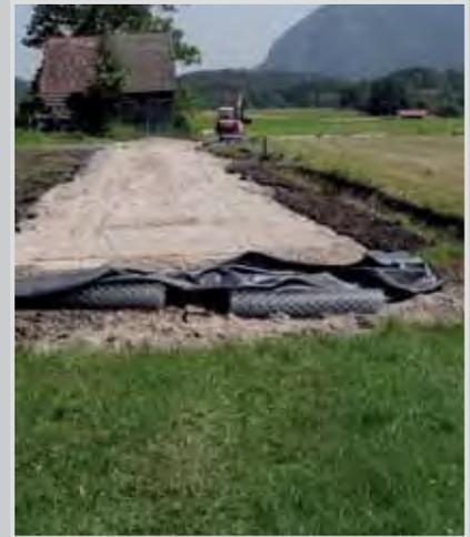
Aufgrund der schwierigen Bodenverhältnisse musste teilweise ein aufwändiger Neubau mit Draht und Vlies gewählt werden.
