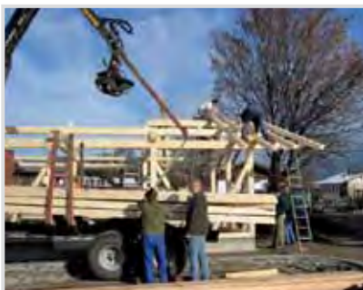
Nach vielen Debatten über Funktion, Größe, Form und Stil des Stadels einigte man sich auf eine rechteckige Form im heimischen Holzbaustil; im Bild Vinzenz Bachmann (Planer), Flori Loferer (Zimmerer), Martin Sabold (Kordinator).
