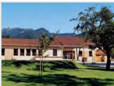
Der neue Schulhof von Süden aus gesehen im Jahre 2005: (Blick auf Rückseite des Atriums); der neue Anstrich der Fassade erfolgte in vielen Arbeitsstunden (Eltern, private Helfer und Fachleute).
