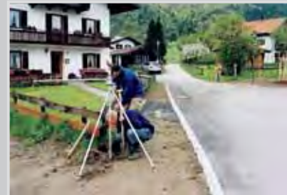
Vermessungsarbeiten (Peter Oster mit seinem Team) westlich des HdG; die Bodenordnung war Voraussetzung für den Bau der neuen Straße.
