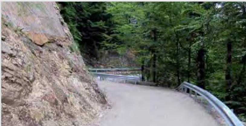
Die Gemeindeverbindungsstraße von Achberg nach Unterwössen musste nach teilweiseem Absturz der Fahrbahn aufwändig saniert werden. Felsvernagelungen, Betonfüllungen, Felssicherungen mit Drahtgeflecht und Spritzbegrünungen wurden im Jahre 2003 als Sicherungsmaßnahmen gegen eine weitere Erosion des brüchigen Felsens durchgeführt. Zudem erhielt ein Teilstück der Straße eine Absturzsicherung durch Leitplanken.
