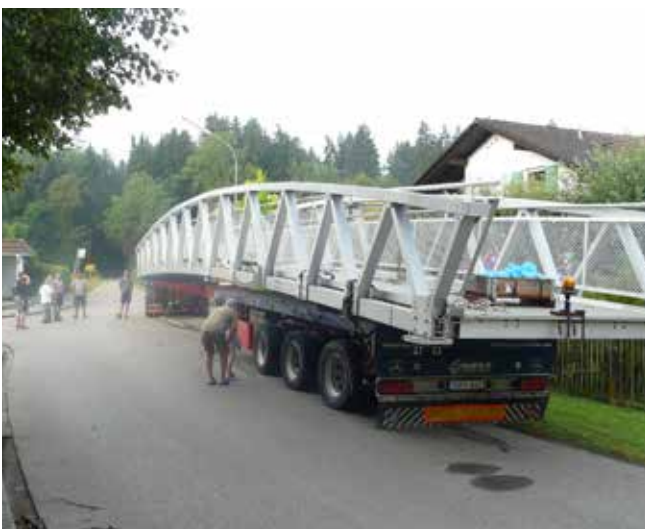
◆ Anlieferung und Einbau des neuen Hackenstegs
