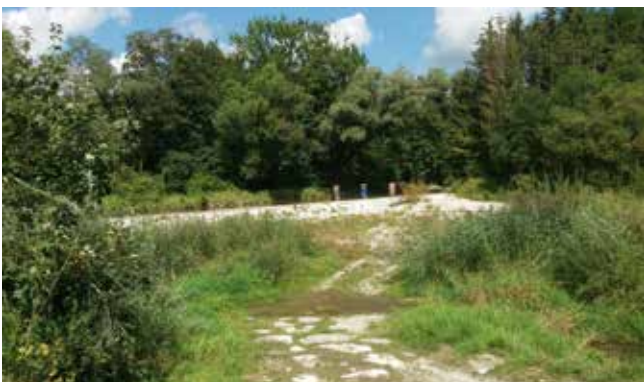
◆ Der Wührübergang durch die Flutmulde wurde bequemer und sicherer gestaltet.
